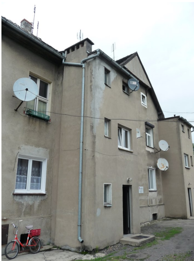
Fot. 2 Elewacja tylna
